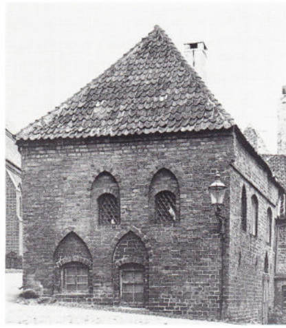
Fig.5. Kælderbod under Vesthuset med adgang fra Brogade/Farvergade. Døren (til højre) er nu delvis dækket ved, at gadeniveauet er hævet.
