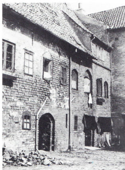
Fig.2. Tuesens Boder, sydsiden før restaureringen.
