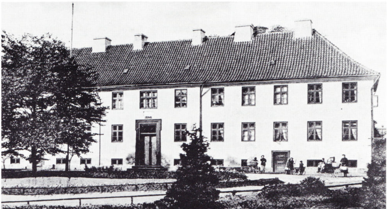
Fig. 10. Ostenfeldts Stiftelse, facaden mod øst, ældre foto.
