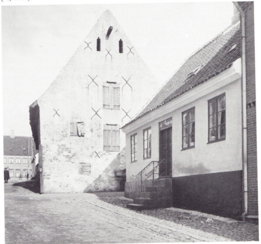
Fig. 3. Kompagnihusets sydgavl før restaureringen i 1920'erne.
