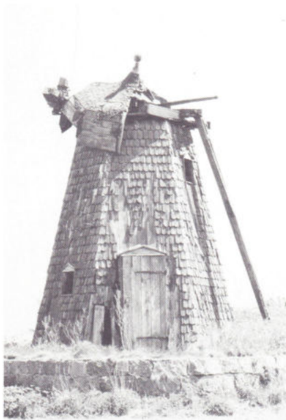
Fig. 3. Ladby Andelsmølle i 1987 med hatten på sned.
