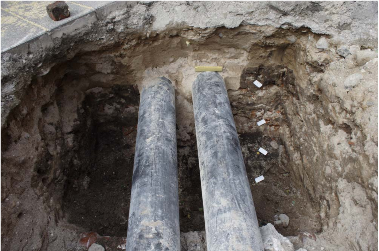
Fig. 3. A1-A4 i vestprofilen ved opgravningen ved Nygade. Set fra øst.
