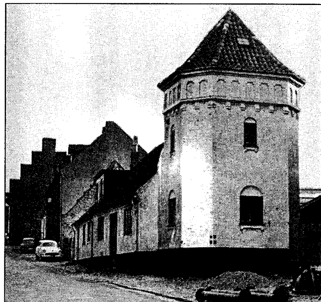
Fig.5. I 1915 blev vandværket flyttet over gaden til Kompagnistræde 11 (5.1). Tårnet på billedet (der her er fotograferet lige inden nedrivningen i 1967) indeholdt en stor vandtank. Det var ikke noget vandtårn i gængs forstand, og man anlagde i samme periode en ny vandbeholder på Åsen ved Præstøvej. Den kan stadig ses lige vest for Sjølundstårnet (vandtårn, bygget 1938). Den store skorsten (2.3) ved kedelhuset blev revet ned, og en ny og mindre (5.2) blev bygget ved sydøsthjørnet af det nye maskinhus (3.1).
