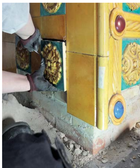
Fotos fra nedtagningen. Bevaring Sjælland.
